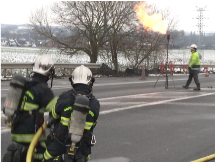
Torchère mise en place afin de vidanger la citerne de propane
